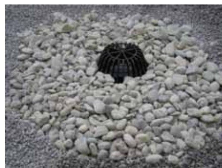
12. Засыпать гравием остальную поверхность кровли
