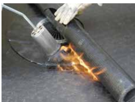
4. Наклеить 2-й слой гидроизоляции (до обжимного фланца)
