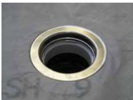
10. Зажать фильтрующий слой фиксирующим фланцем элемента HL350.0
