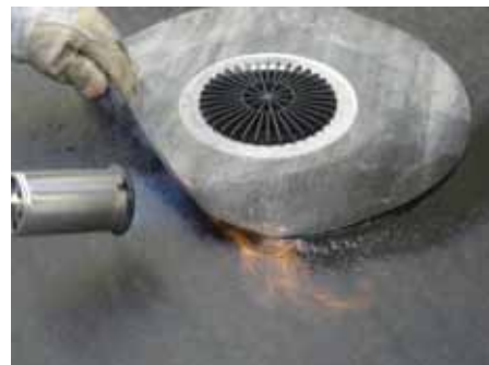
3. Приварить полимербитумное полотно воронки
