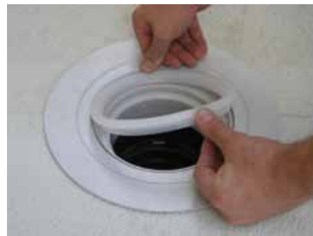
9. Убедиться в правильности установки прозрачного пластикового кольца
