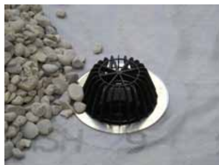
11. Установить листоуловитель, выполнить засыпку гравием (фракция: 20+40 мм)
