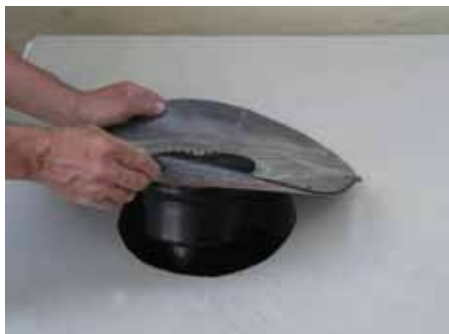
1. Проделать отверстие Ø 255мм, закрепить воронку HL62H
