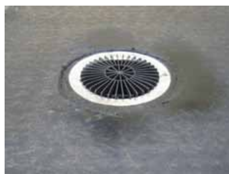
5. Так должна выглядеть воронка после укладки гидроизоляции
