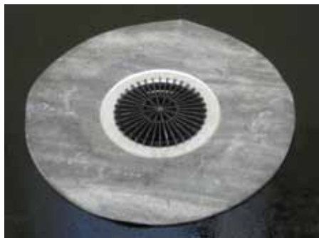
2. Нанести праймер, наклеить 1-й слой гидроизоляции
