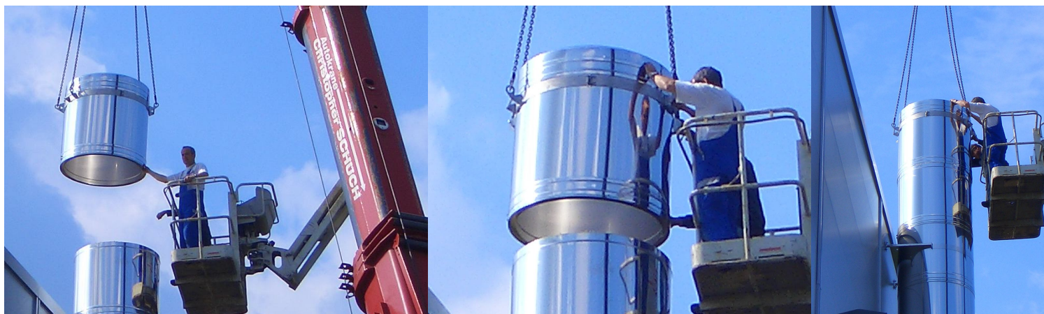
Рис. 22 Пример монтажа при помощи приспособления
