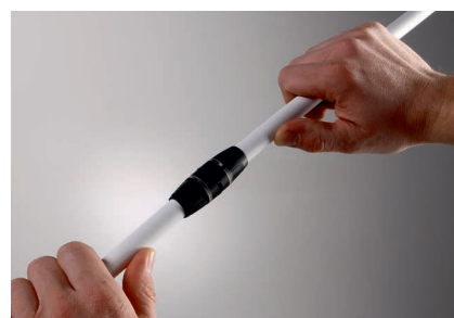
...соединяем трубу и фитинг.
