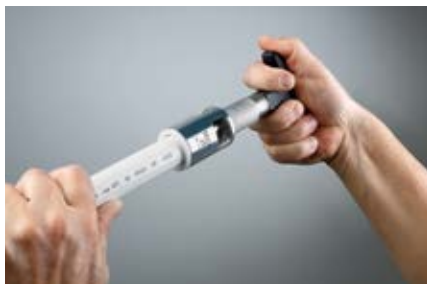
Калибровка и снятие фаски
