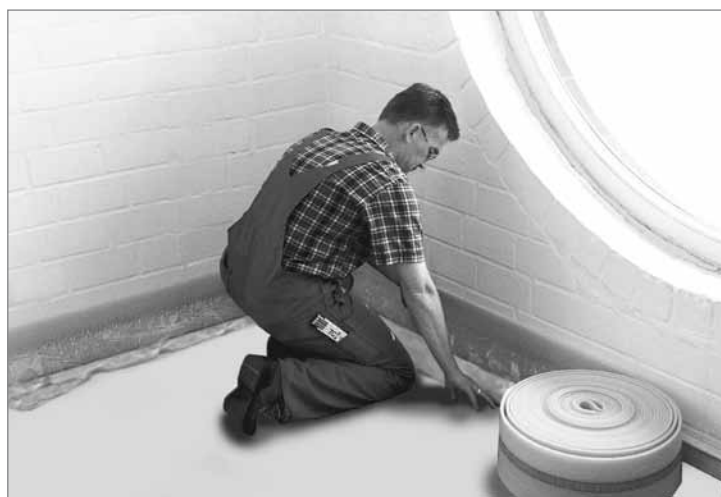
Укладка демпферной ленты
