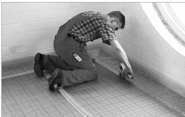
Уплотнение краевых изоляционных полос
