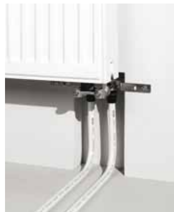
Подключение радиатора с использованием настенного монтажного узла
