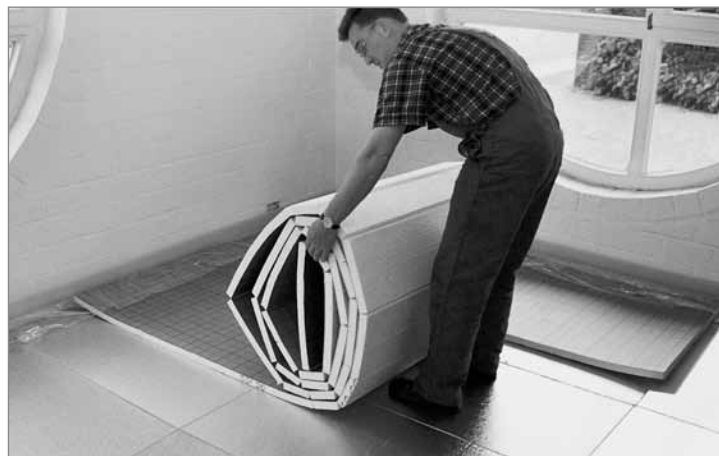
Укладка рулонной изоляции
