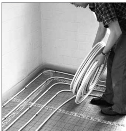
Укладка трубопровода
