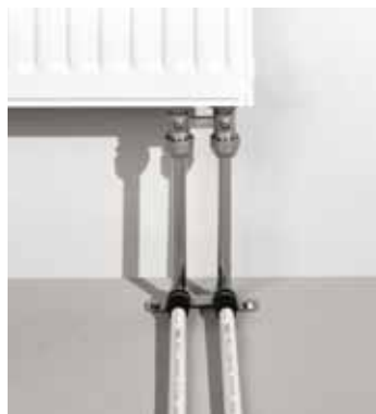
Подключение радиатора с использованием монтажной трубки
