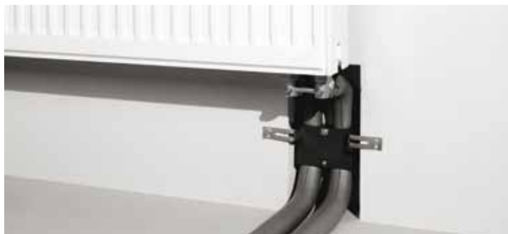
Подключение радиатора с использованием настенного монтажного узла
