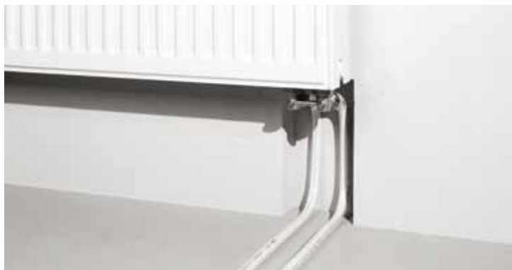
Подключение радиатора из стены
