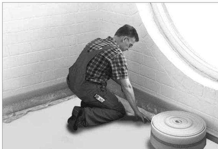
Укладка демпферной ленты
