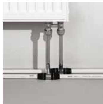
Подключение радиатора с использованием проходной трубки
