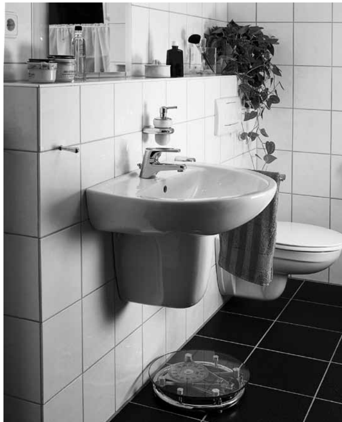
Завершенная перегородка с санфаянсом
