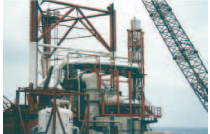
Рис. 7.5. Пример энергетической установки, состоящей из газовой турбины и парового котла-утилизатора серии Vitomax 200 HS АНК
