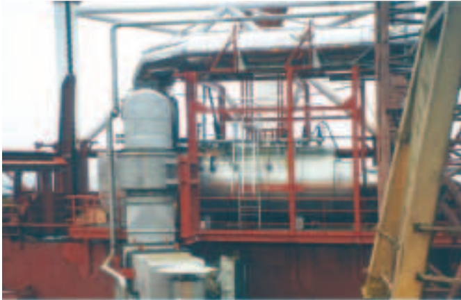
Рис. 7.5. Пример энергетической установки, состоящей из газовой турбины и парового котла-утилизатора серии Vitomax 200 HS АНК
